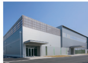
日立オートモティブシステムズ開発試験棟
